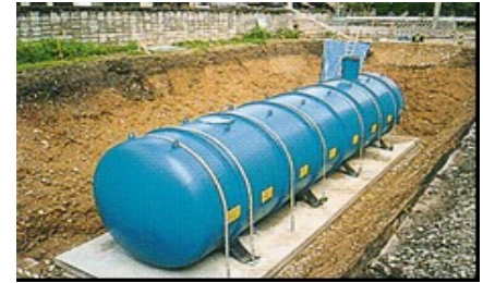
【耐震性貯水槽】
